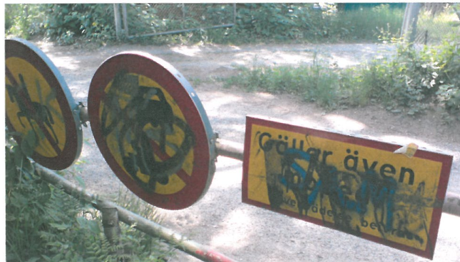
Exempel på vägmärken som behöver bytas ut
