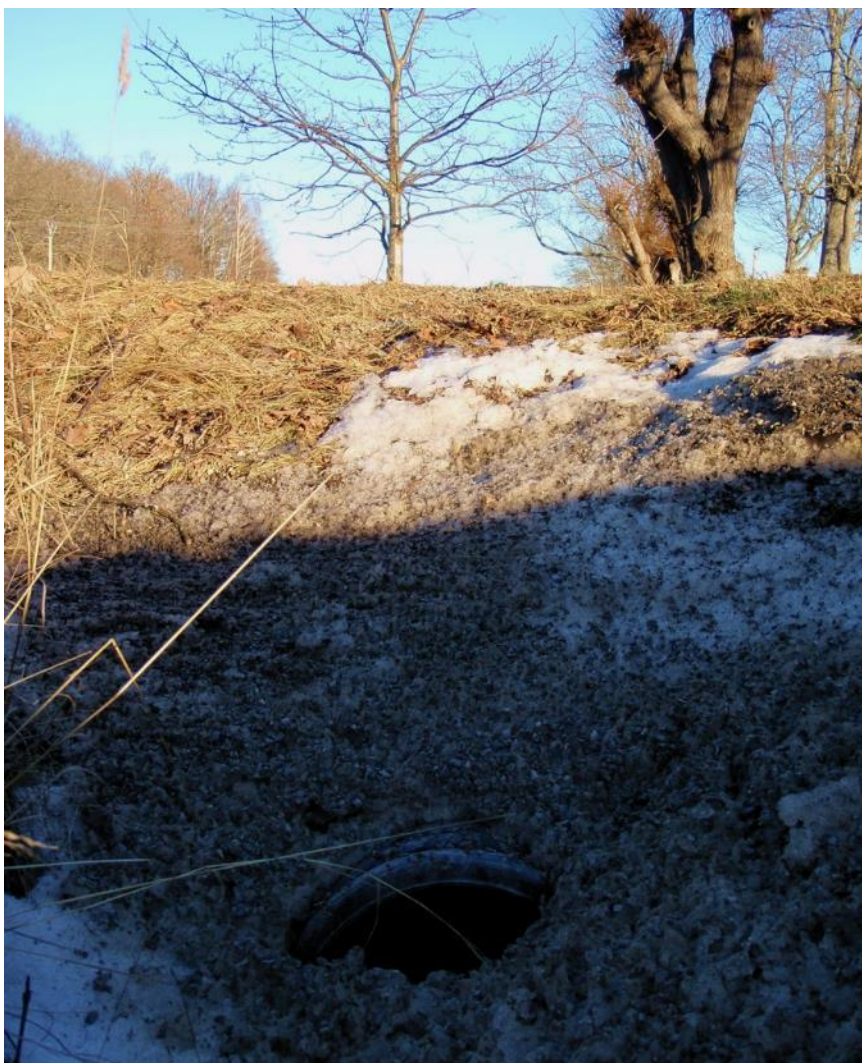
Figur 8. En delvis igensatt trumma i vägdiket längs med Ekebyhovsallén.
