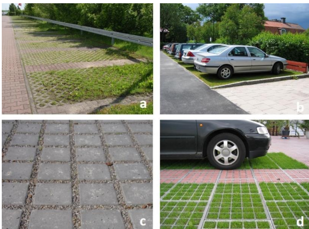
Figur 20. Exempel på användning av genomsläppliga material på parkeringsytor. (a) Gräsarmering med betonghålsten, (b) gräsarmering med "Pelle-platta" [www.vegtech.se], (c) Marksten med glesa, genomsläppliga fogar, (d) Gräsarmeringsplattor [alltimark.se].
