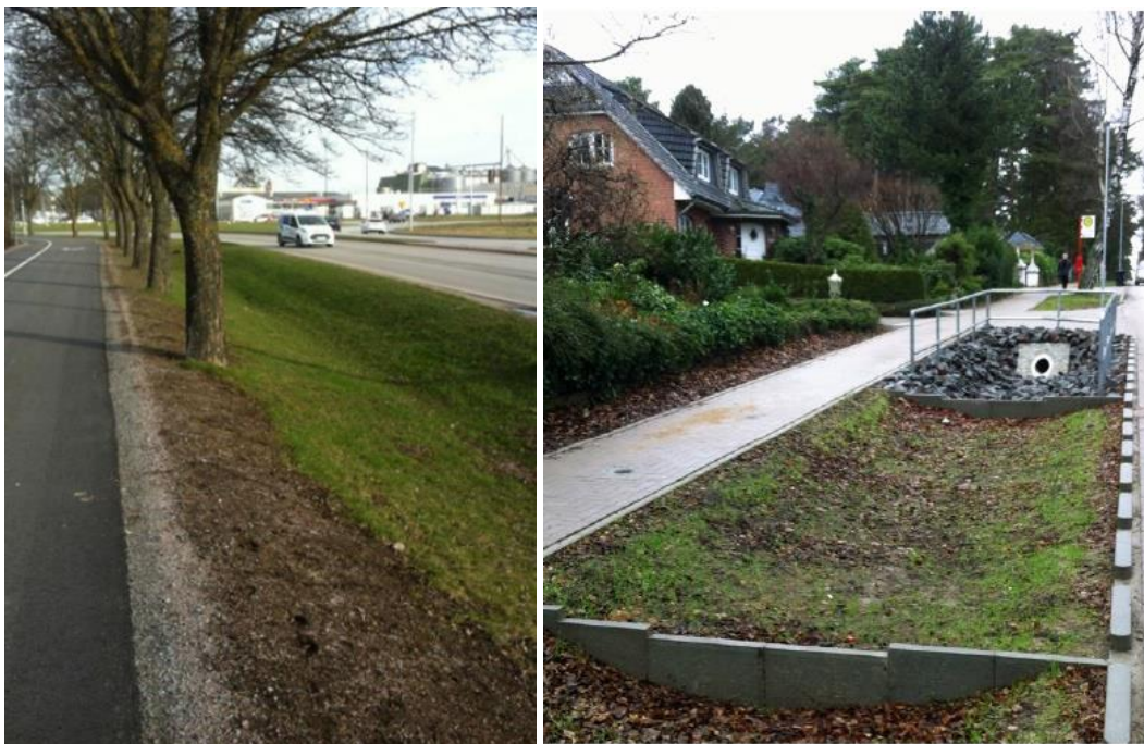
Figur 23. (T.v.) Svackdike mellan GC-väg och bilväg i Uppsala. (T.h.) Svackdike med erosionskyddat inlopp i makadam och sektioner med dämmen.
