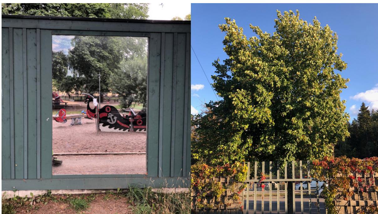
Exempel på bullerskydd med genomsiktliga partier.
