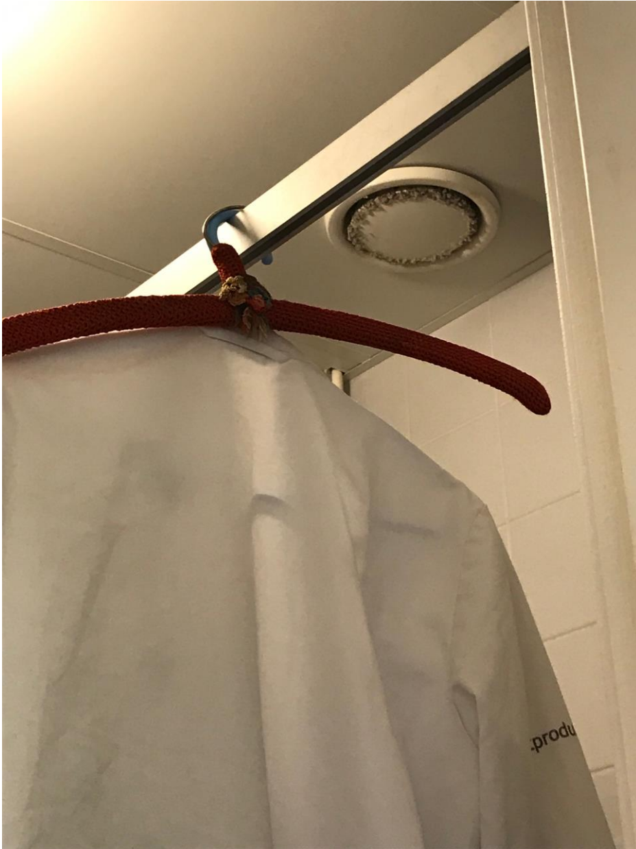
Bild 2. Damm vid fläkten
