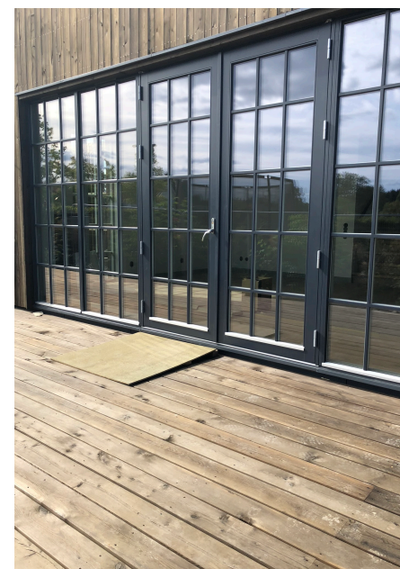
Exempel på fasad, fönster och terrass.
