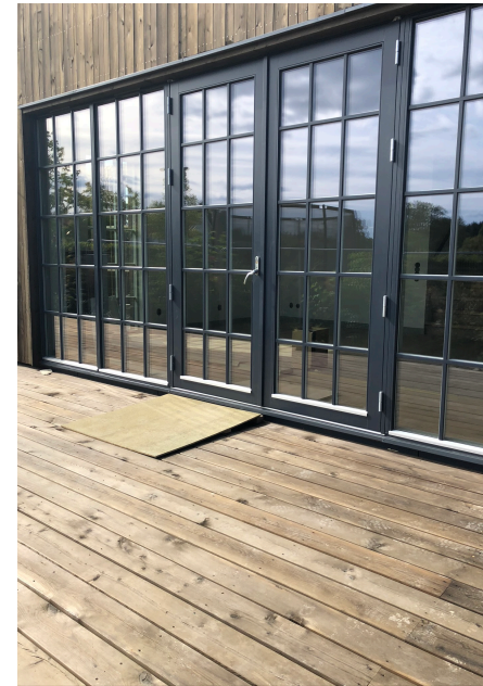
Exempel på fasad, fönster och terrass.
