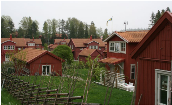
Bild 25. Den nytillkomna bybebyggelsen har uppförts och återanvänt äldre byggnadselement såsom exempelvis färgsättning, takmaterial och gärsgårdar. Området Segersäng, Nynäshamn.
