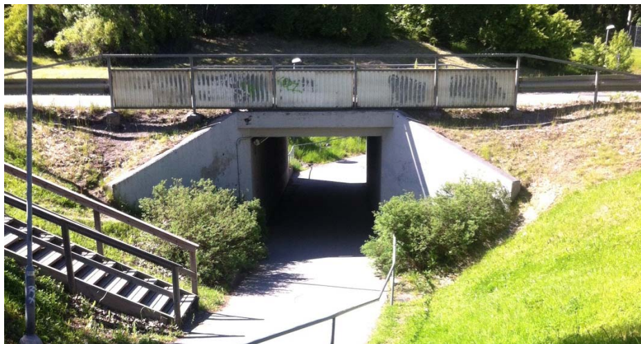
Figur 7. Viadukt under huvudleden mellan Ekerö centrum och Sandudden.
