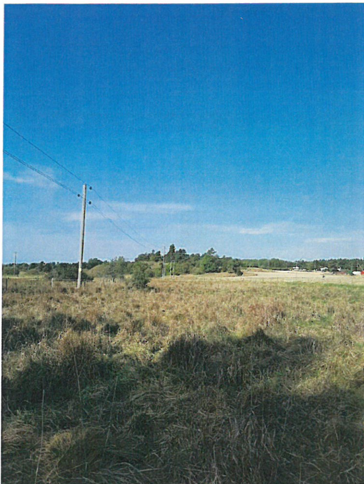
Figur 10. Befintlig 20 kV ledning i betesmark (öster om Törnbyviken), vy mot nordväst.
