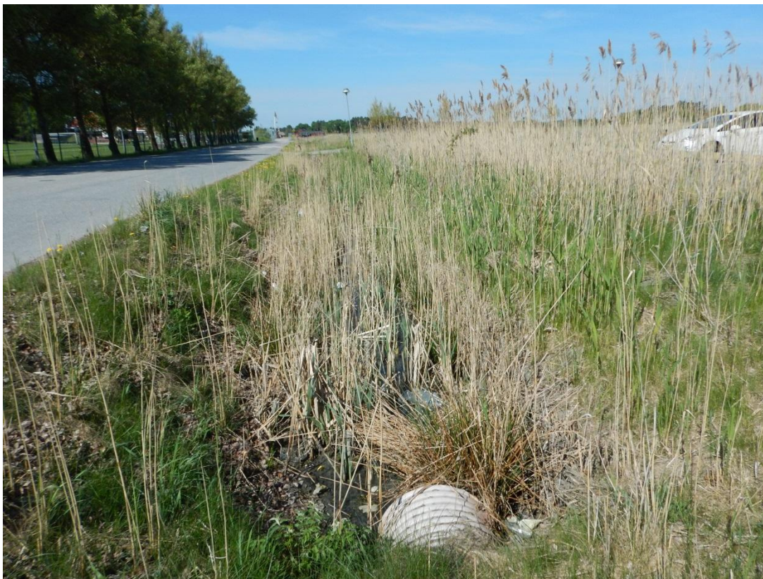
Utlopp i Berga-Törnby markavvattningsföretag.
