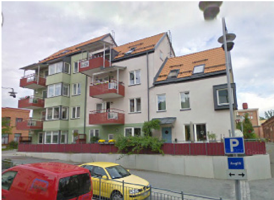
Exempel på varierad höjdsättning och tak med takpannor som avslutas med plåt (Järla sjö, Nacka).
