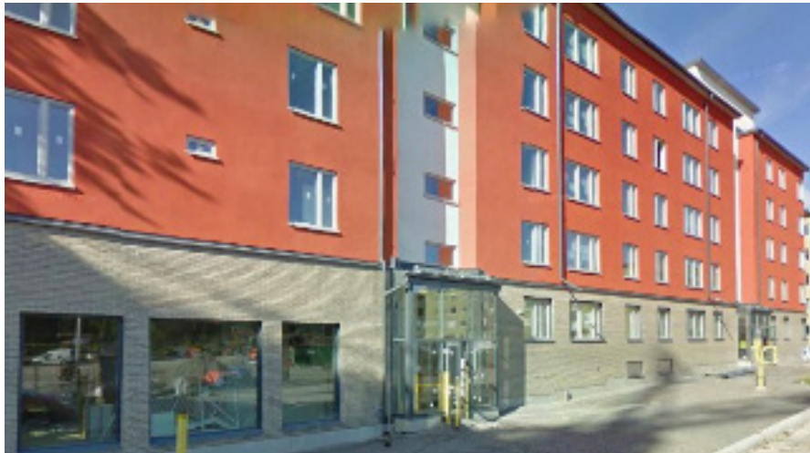
Exempel på byggnader med tydligt markerad sockel i tegel.
