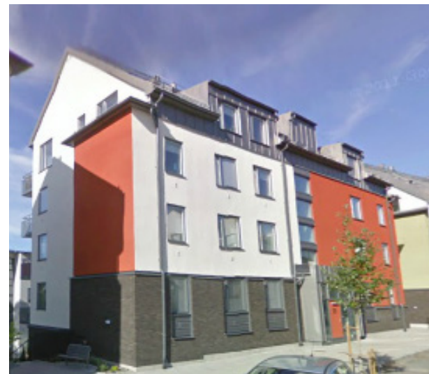
Exempel på byggnad med vindskaraktär och takkupor, samt sockel i tegel.
