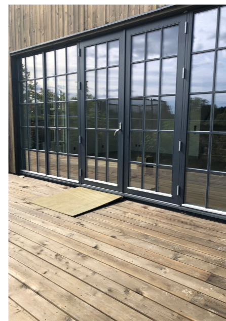
Exempel på fasad, fönster och terrass.
