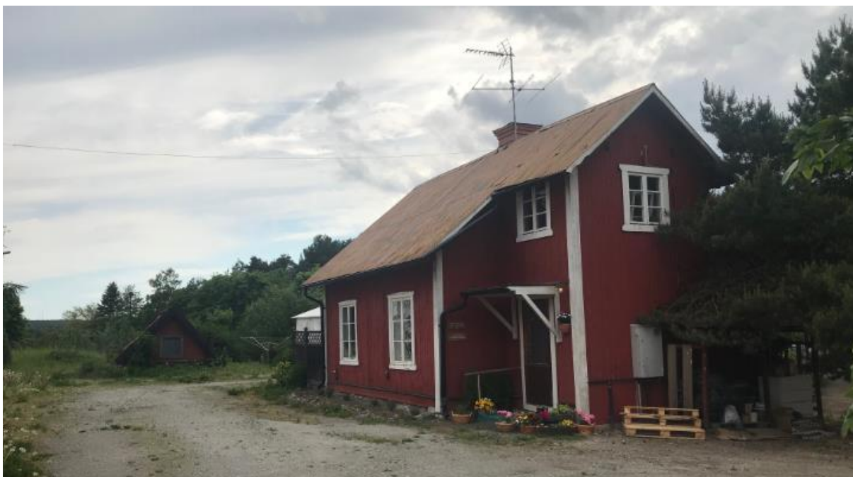
Figur 9. Byggnad Skå Eneby 2:8 i ett-två plan. Byggnaden har faluröd panel med vita spröjsade fönster och snickerier. Några av byggnaderna hyrs ut för bostadsändamål.
