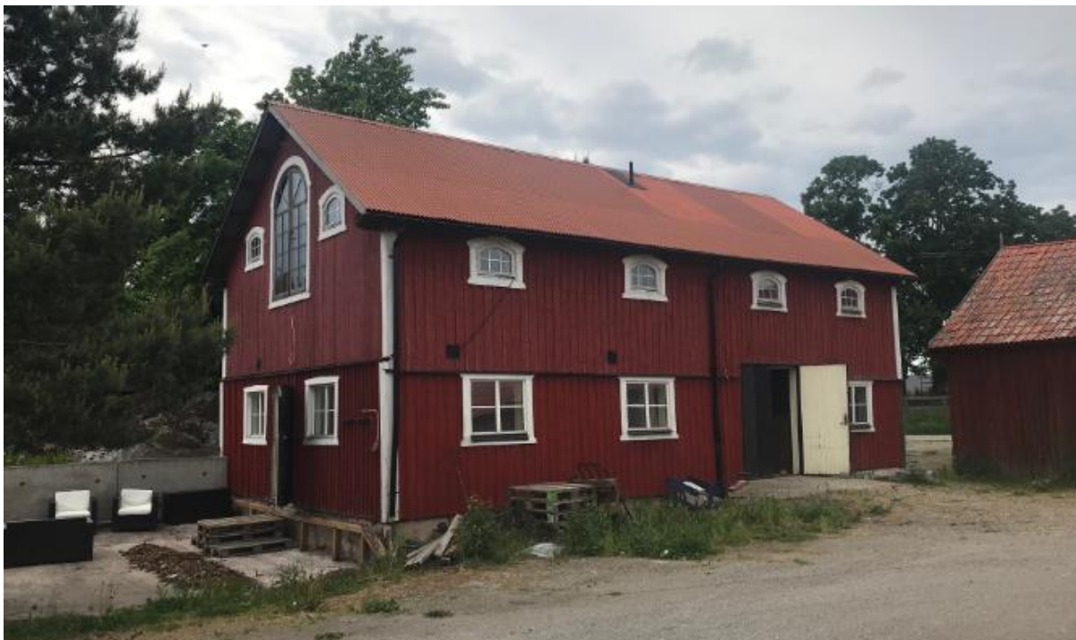
Figur 8. Byggnad Skå Eneby 2:8 med faluröd träpanel i två våningar. Fönstren är vita och har spröjs. Fönstren på övervåningen har välvda överstycken. Gaveln har berikats med en större småspröjsat fönster med lunettkröning. Några av byggnaderna hyrs ut för bostadsändamål.
