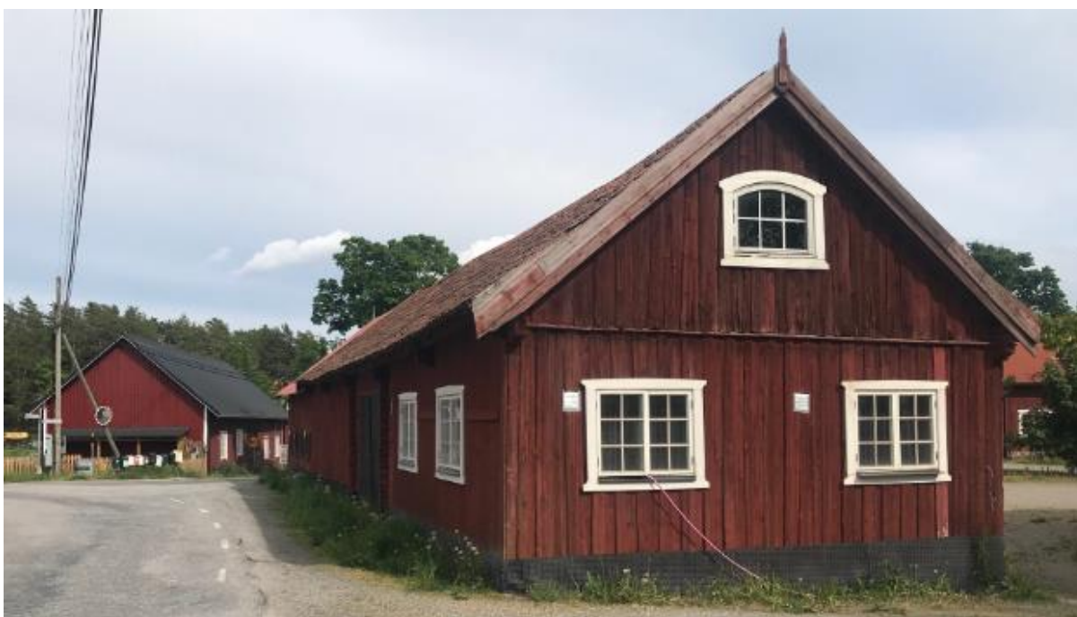
Figur 7. Äldre lada på Skå Eneby 2:8 som troligtvis devis är inredd. Byggnaden har faluröd panel med vita småspröjsade fönster. Taket kröns av en spira i trä.
