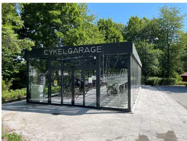
Figur B.2.19. Exempel på cykelgarage med både tvåvåningsställ och raka ställ i markplan i Enköpings kommun. Ett cykelgarage erbjuder cyklister en trygg och attraktiv cykelparkeringslösning med ramlåsning och väderskydd. Cykelgarage kan också erbjuda andra servicefunktioner såsom förvaringsboxar, laddmöjligheter för elcyklar, cykelpump, tvätt- och reparationsmöjligheter. Foto: Sebastian Lindell, Enköping kommun.
