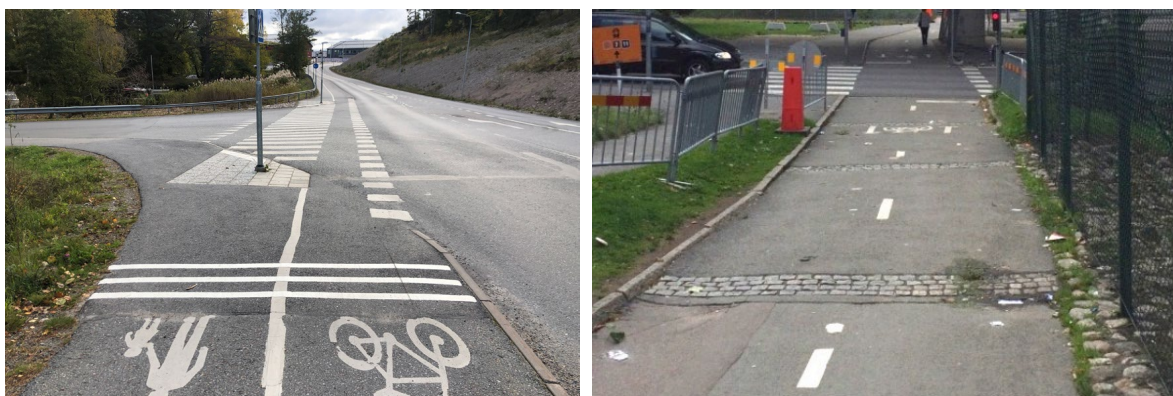
Figur 91-92. Bullerremsor (rumble strips) som målats i gång- och cykelbanan inför en korsning på Bryggavägen till vänster. Gatstensrader som anlagts i intervaller inför en signalreglerad korsning i Gamlestaden, Göteborg till höger.
