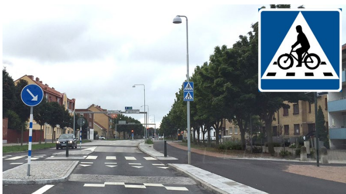
Figur 101. Exempel på en kombinerad cykelöverfart med övergångsställe med avsmalning, mittrefug och upphöjning.
