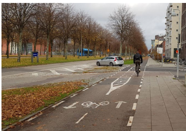
Figur 93. Exempel på en nudging-åtgärd i Göteborg där cykelbanan smalnats av med en visuell målning.
