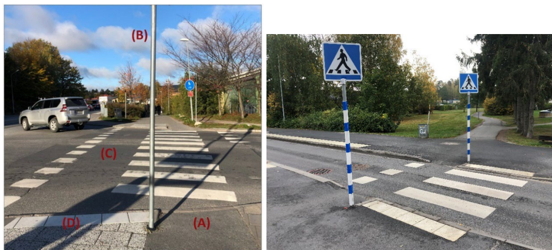
Figur 28 (tv) och 29 (th). Exempel på övergångsställen med cykelpassager som är i behov av en ny utformning. Den vänstra bilden visar korsningen Bryggavägen/Ångbåtsvägen. Cykelpassagen (A) är för smal i proportion till hela övergångsställets bredd och trafikflödet av cyklister. Skylten (B) minskar cyklisters utrymme att cykla över passagen. Vägmarkeringen (M16) för cykelpassagen var dessutom felaktigt målad (men har emellertid åtgärdats). Den högra bilden visar korsningspunkten vid busshållplatsen Klövervägen på Väsbyvägen. Skyltarna är snedvridna och bör flyttas eftersom dess placering minskar cyklisternas utrymme att cykla över passagen.
