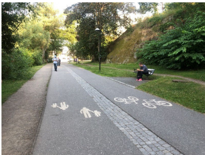
Figur 73. Exempel på hur en separerad dubbelriktad gång- och cykelbana kan utformas i parkmiljö. Gång- och cykelbanan har samma markbeläggning men separeras på ett tydligt sätt med avvikande material i form av fem rader med gatsten. Gång- och cykelsymbolerna tydliggör separeringen ytterligare. Exempel från Kungsholms strand i Stockholms stad.
