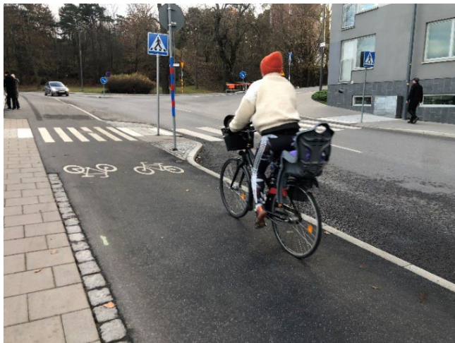
Figur 67. Exempel på en dubbelriktad cykelbana som separeras med kantsten mot körbanan. Mot gångbanan separeras cykelbanan med en rad gatsten. Bilden är tagen i Hornsbergs Strand i Stockholms stad.
