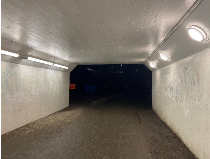
Figur 103. Tappströmstunneln i Ekerö är ett exempel på en tunnel där kontrasten mellan ljuset i tunneln och belysningen utanför är för stor. Den stora kontrasten minskar möjligheten att upptäcka hinder eller andra gående och cyklister utanför tunneln i tid, vilket kan resultera i krockolyckor om cyklister färdas i hög hastighet.
