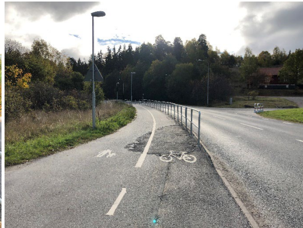
Figur 24 (tv) och 25 (th). Gång- och cykelbanan mellan Fantholmsvägen och Ekerövallen längs Jungfrusundsvägen (vänster) samt gång- och cykelbanan mellan skidbacken och Herredagsvägen längs Bryggavägen (höger) separeras mot biltrafik med metallräcke. Räcken innebär en hög skaderisk vid singelolyckor för cyklister och minskar utrymmet för gående och cyklister.
