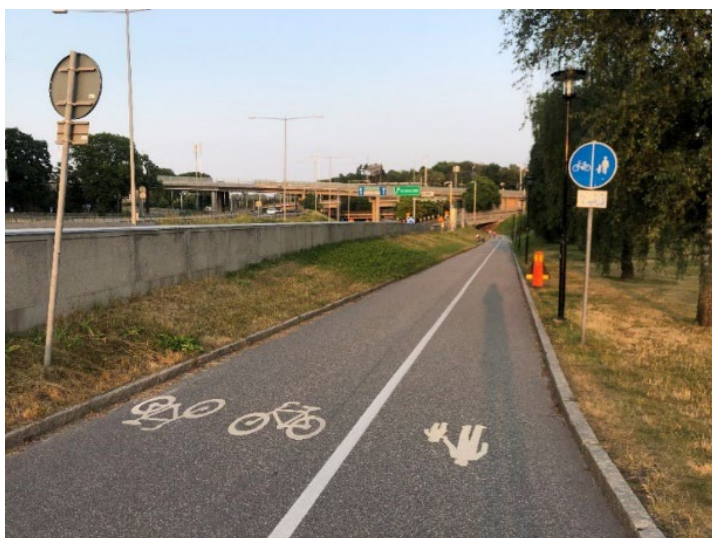
Figur 72. Exempel på en dubbelriktad gång- och cykelbana som separeras med en målad heldragen linje (M8). Vägmarkeringen (D7) och gång- och cykelsymbolerna förtydligar vilken bana respektive trafikant ska använda. Bilden är tagen från Drottningholmsvägen i Stockholms stad.
