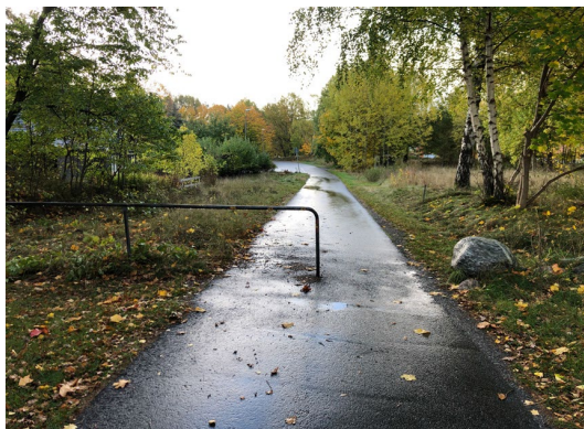
Figur 87-88. Bilhinder placerat på en oseparatorad gång- och cykelbana i form av grindar och räcke.
