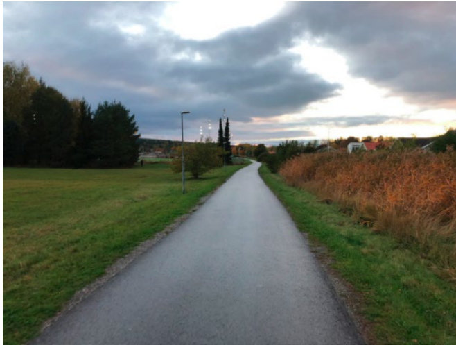
Figur 71. Friliggande gång- och cykelväg i Ekebyhovsdalen mot Träkvista idrottsplats i Ekerö.
