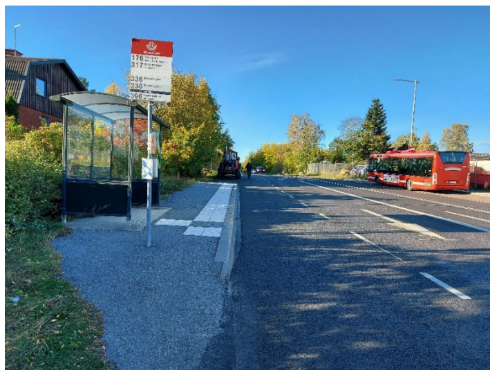
Figur 43. Vid korsningen Mörbyvägen längs Färentunavägen saknas det en länk i gång- och cykelvägnätet eftersom busshållplatsen tar upp all plats. Trafikverket håller på med åtgärdsvalstudie här.
