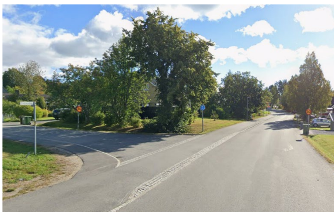
Figur 99–100. Skiss på principutformning av en genomgående gång- och cykelbana (till vänster). Bild på principutformning av en genomgående kombinerad gång- och cykelbana som ingår i vägens väjningsplikt som korsar en tvärgata: Strömnäsgatan, Piteå (till höger).
