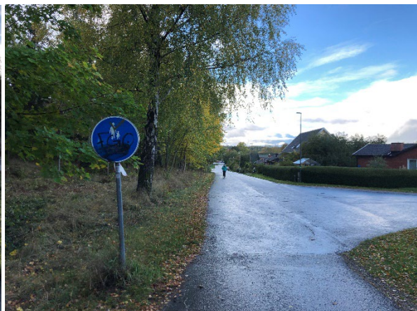
Figur 41 (tv) och 42 (tv). Den vänstra bilden visar ett exempel på ett felaktigt uppsatt vägmärke: D7 anger att banan är delad i två banor, en för gående och en för cyklister, vilket den i verkligheten inte är. Den högra bilden visar ett exempel på ett nerklottrat vägmärke.
