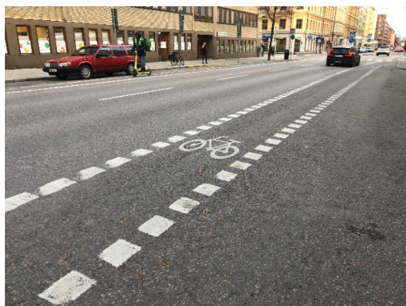
Figur 69 (tv) och 70 (th). Cykelfält längs Fleminggatan i Stockholms stad markerat med cykelfältslinje M5 och cykelsymboler. Cykelfält kan med fördel markeras med en avvikande färg vid korsningar för att förtydliga cyklistens utrymme i gaturummet (till höger) men färgen har ingen betydelse enligt Trafikförordningen.
