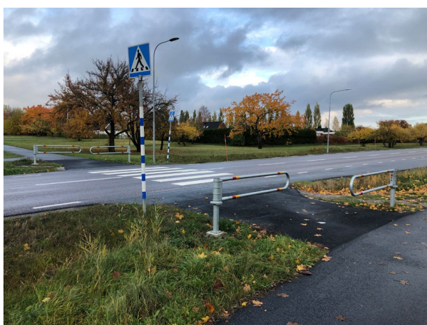
Figur 90. Farthinder i form av cykelgrindar.
