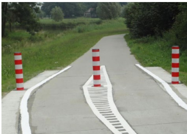
Figur 89. Exempel på utformning av bilhinder med pollare från Nederländerna. Pollare ger bättre framkomlighet för cyklister från Nederländerna än exempelvis bommar och grindar.
