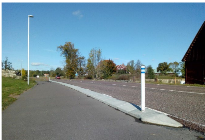
Figur 68. GCM-stöd på länsväg 628 i Mönsterås kommun.
