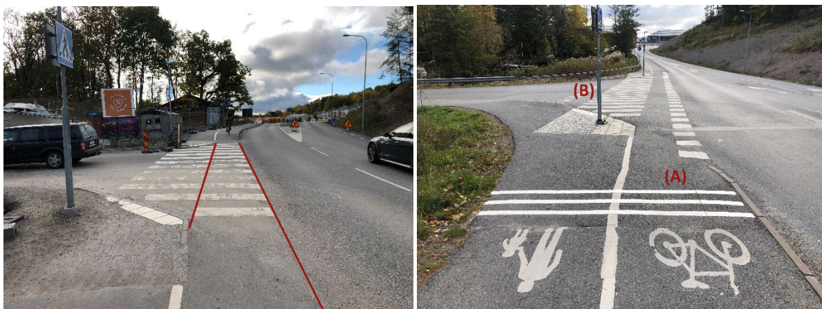
Figur 30 (tv) och 31 (th). Två andra exempel på övergångsställen med cykelpassager som är i behov av en mer lämplig utformning. På den vänstra bilden (Jungfrusunds marina) saknas det en vägmarkering för cykelpassage (M16). Vid korsningen Bryggavägen/Herredagsvägen (höger) är stolpen (B) felplacerad mitt i gångbanan vilket försämrar gåendes framkomlighet.
