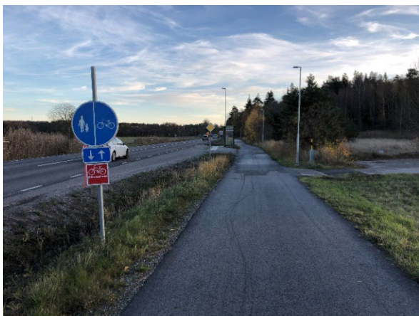
Figur 41 (tv) och 42 (tv). Den vänstra bilden visar ett exempel på ett felaktigt uppsatt vägmärke: D7 anger att banan är delad i två banor, en för gående och en för cyklister, vilket den i verkligheten inte är. Den högra bilden visar ett exempel på ett nerklottrat vägmärke.
