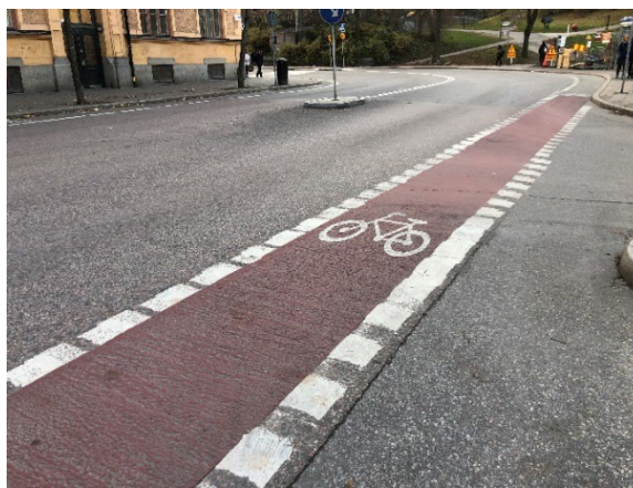
Figur 69 (tv) och 70 (th). Cykelfält längs Fleminggatan i Stockholms stad markerat med cykelfältslinje M5 och cykelsymboler. Cykelfält kan med fördel markeras med en avvikande färg vid korsningar för att förtydliga cyklistens utrymme i gaturummet (till höger) men färgen har ingen betydelse enligt Trafikförordningen.
