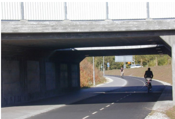
Figur 104. Exempel på planskild tunnel för gång- och cykeltrafikanter i Lund. Den anslutande gång- och cykelvägen har mjuka radier där gående och cyklister har god sikt genom tunneln. Belysningsstolpar som placeras innan och efter tunneln bidrar också till god sikt under de mörkare timmarna av dygnet.
