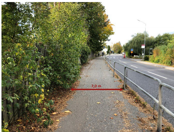
Figur 24 (tv) och 25 (th). Gång- och cykelbanan mellan Fantholmsvägen och Ekerövallen längs Jungfrusundsvägen (vänster) samt gång- och cykelbanan mellan skidbacken och Herredagsvägen längs Bryggavägen (höger) separeras mot biltrafik med metallräcke. Räcken innebär en hög skaderisk vid singelolyckor för cyklister och minskar utrymmet för gående och cyklister.
