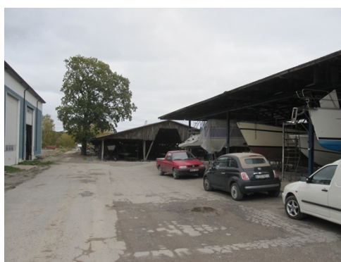
Varvshallar för vinterförvaring (1-4), samt takkonstruktioner (5-6)
