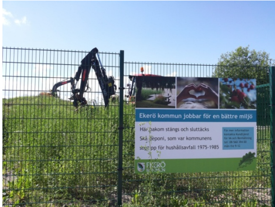
Bild vänster: Start sluttäckning Skå deponi, 2013-06-24.
