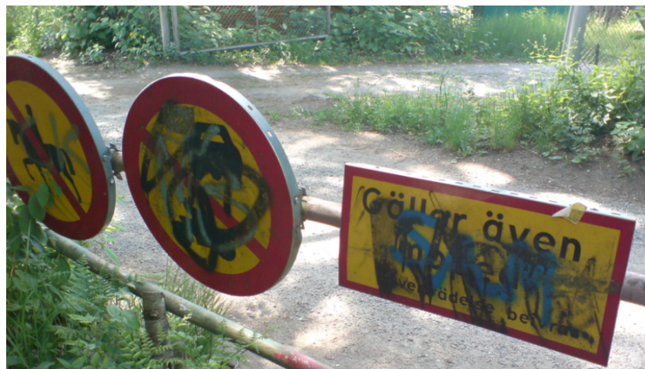
Exempel på vägmärken som behöver bytas ut
