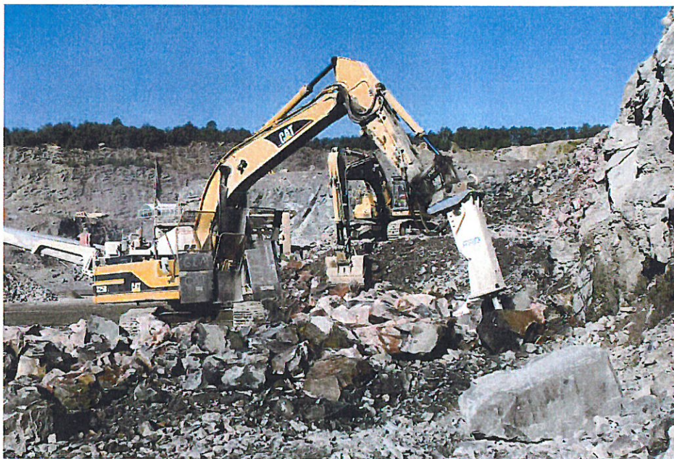
Figur 4.3 Grävmaskin försedd med hydraulhammare
