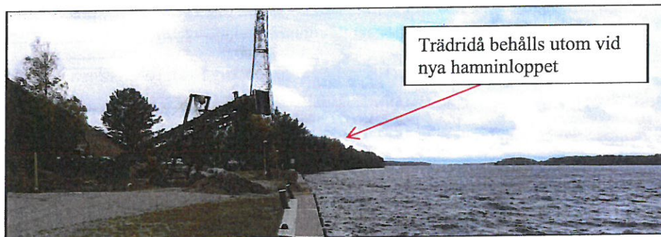
Figur 6.2 Vy från väster, pilen vid ungefärligt läge entreprenadbergslager
