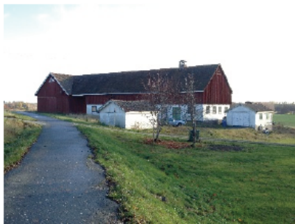
Ladan sedd norrifrån, på gångvägen vid Kungsbergavägen
