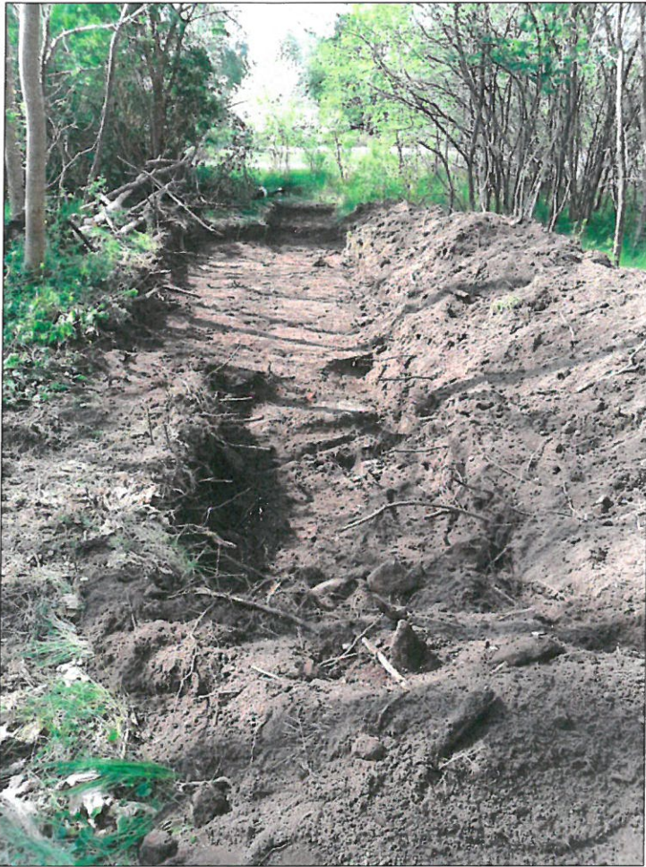
Figur 12. Foto över schakt med indikation. Foto från N mot vägen.
