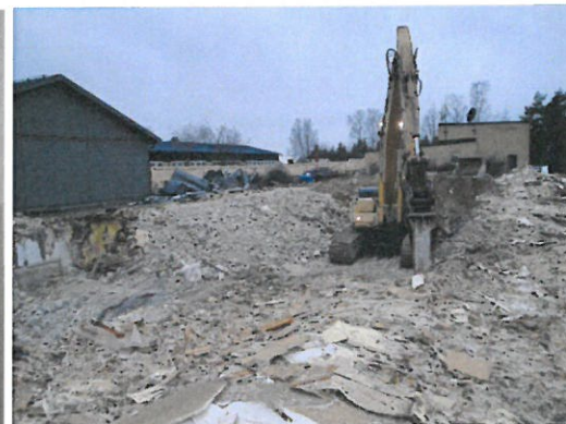
Rivning av hus L på Närlundaskolan
