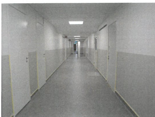
Renovering/ombyggnad i hus A på Närlundaskolan
