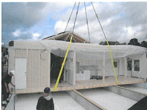
Montering av hus B på Närlundaskolan
