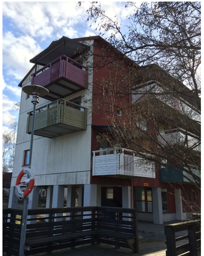
Befintligt bostadshus i Ekerö centrum
