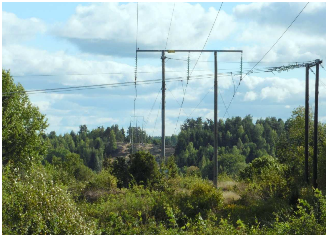
Landskapet vid 70 kV-avgreningen vid Västra Grindstugan.
