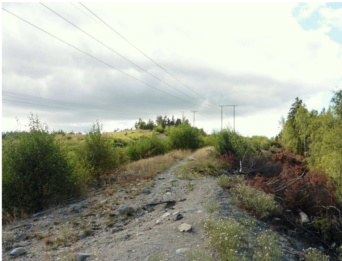
Figur 21. Befintlig 70 kV ledning är belägen på Uppsalaåsen, här strax väster om transformatorstation Älvnäs, vid fd grustäkten.
