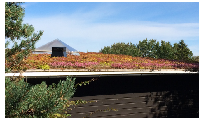
Sedumtak med goda egenskaper för att hantera vatten.
