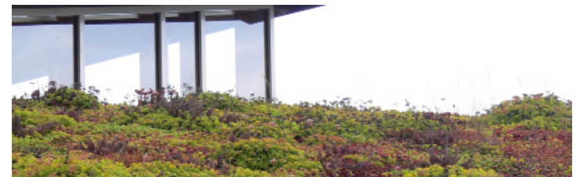
Sedumtak minskar dagvattenavrinningen.
