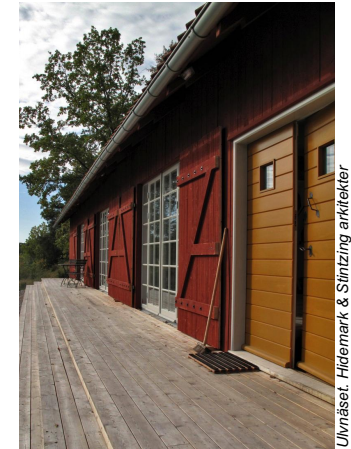
Stora fönsteröppningar med luckor/portar
