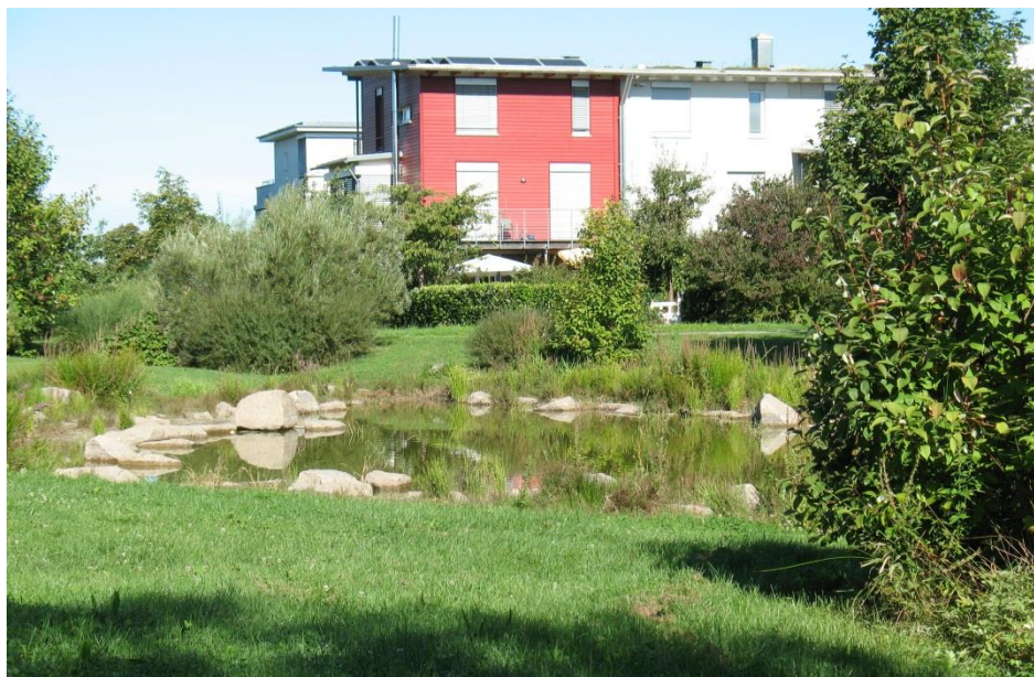
Figur 18. Dagvattendamm. Bild från stadsdelen Rieselfeld i Tyskland 2011.
