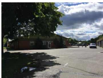
Tappsund 1:1, tekniskt förråd
