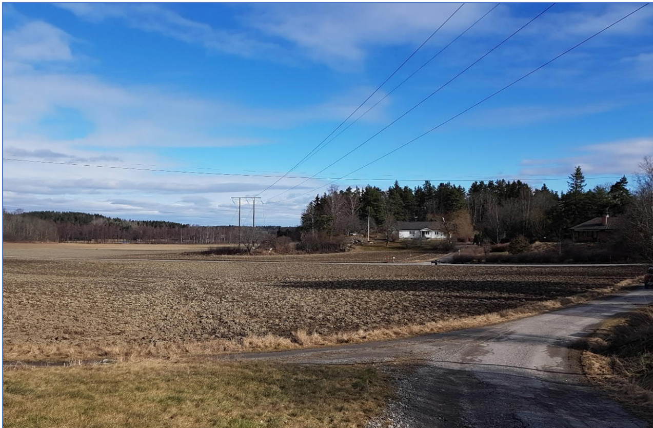
Bild 3. Foto över befintlig 70 kV ledning väster om Sundby och inom riksintresseområde för kulturmiljövården.
