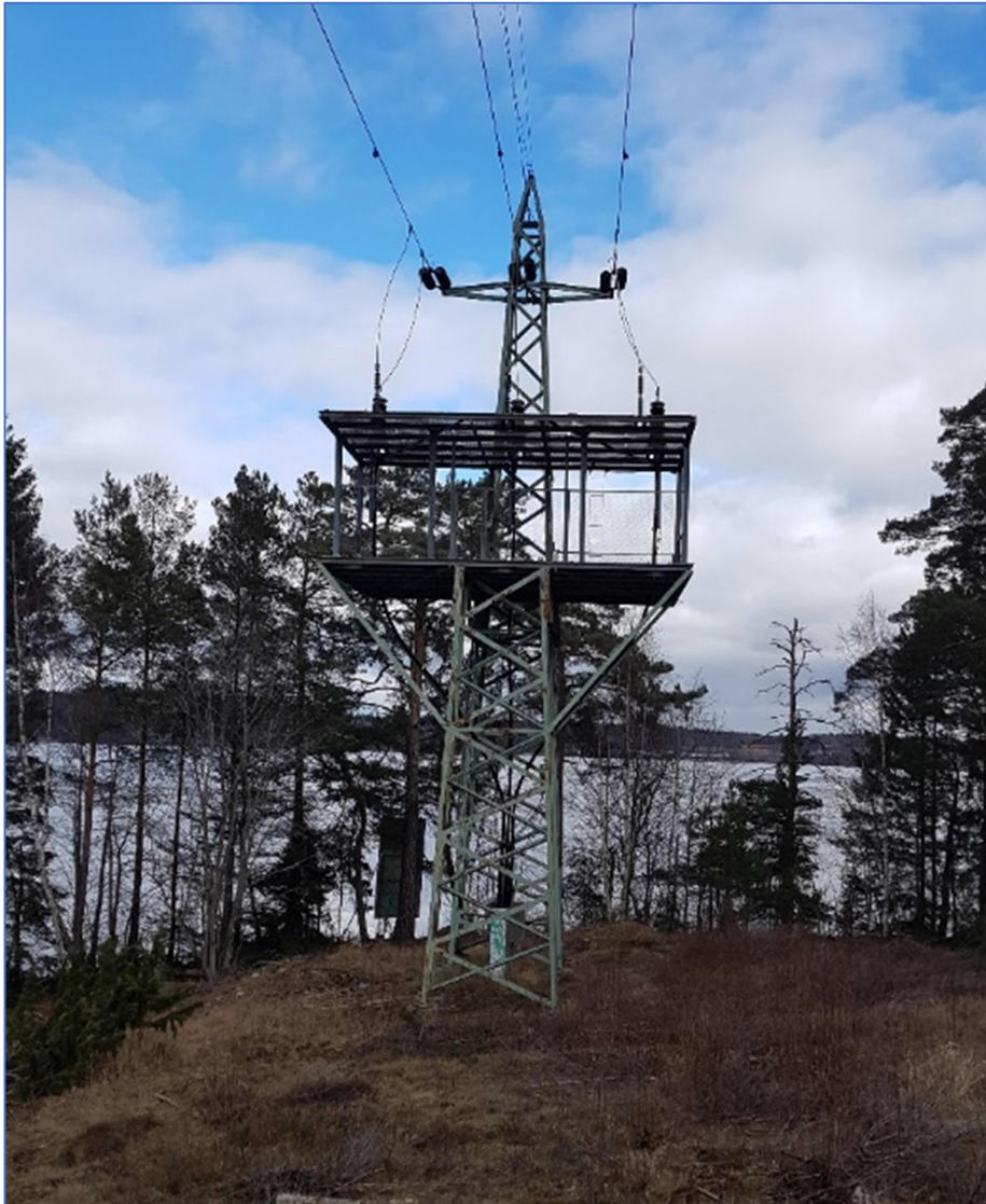
Bild 1. Foto på befintlig sjökabelstolpe på Färingsö som kommer att raseras.
