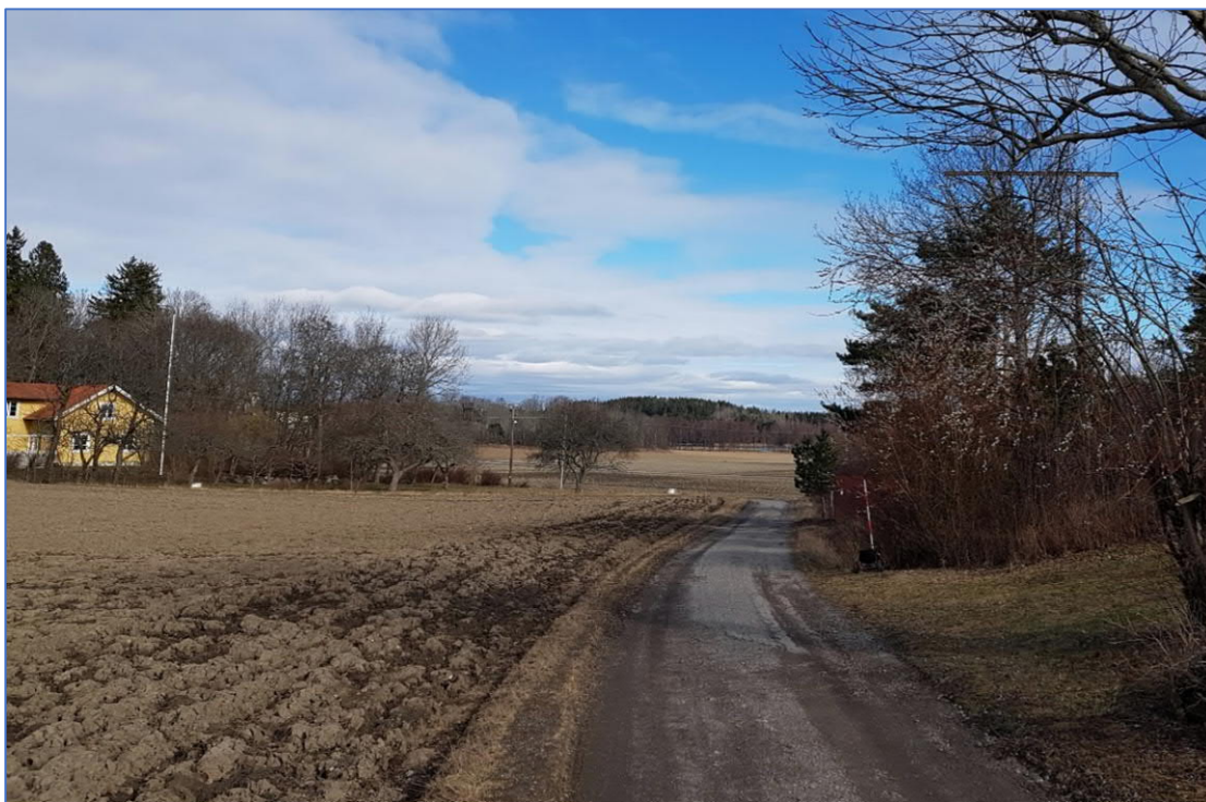
Bild 5. Foto över passage för ledningsalternativ 1B i den västra delen av Sundby. Befintlig 70 kV ledning skimras i bildens högerkant.
