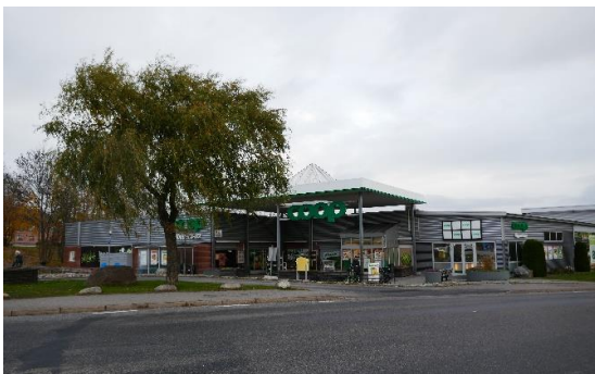
Coops entré sedd från Solbackavägen. Entrén utgör en viktig mötesplats i Stenhamra
