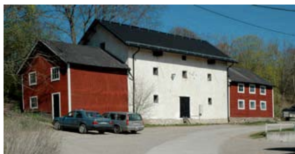
Vitputsat magasin från 1700-talet med tillbyggnader troligen från tidigt 1900-tal. *
