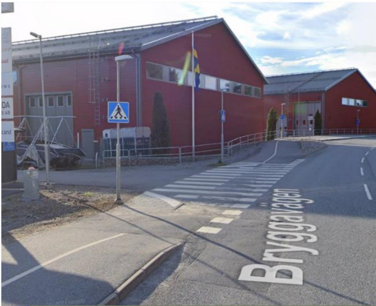
Figur 63. Nuvarande passage vid infart till marinan. Där gång- och cykelvägen korsar Ångkvarnsvägen finns det ingenting som visar att bilvägen korsar en gång- och cykelväg. Det är en otydlig korsning för samtliga trafikanter.
