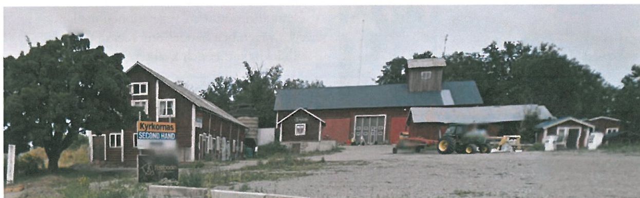
Stora kulturbyggnader på Färentunavägen som är placerade i vinkel mot varandra. Bild: Google maps, 2013
