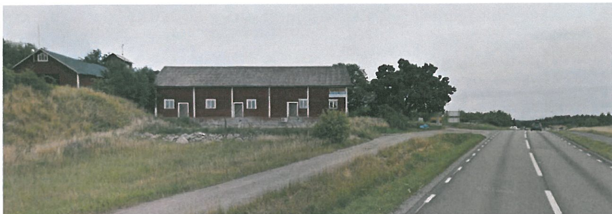
Fasad på kulturbyggnad på Färentunavägen. Bild: Google maps, 2013
