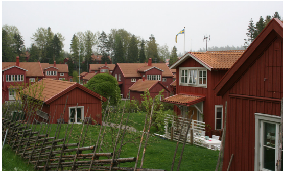
Bild 22. Den nytillkomna bybebyggelsen har uppförts och återanvänt äldre byggnadselement såsom exempelvis färgsättning, takmaterial och gärsgårdar. Området Segersäng, Nynäshamn.
