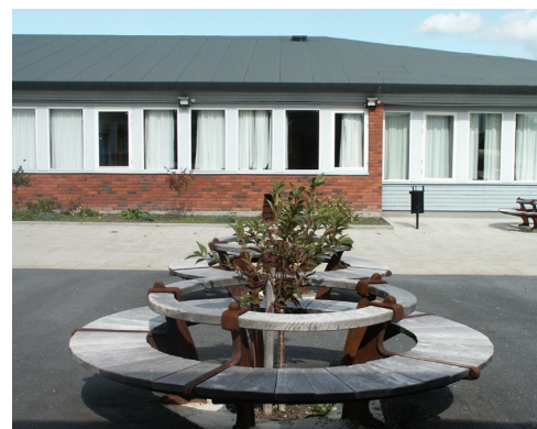
Bild 4. Skolgårdsmiljö vid Stenhamra Skola, Färingsö.
