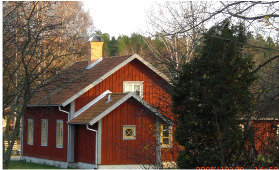
Bild 25. Den mindre tillbyggnaden har bland annat anpassats till den ursprungliga byggnadens takvinkel och färgsättning. Adelsö.
