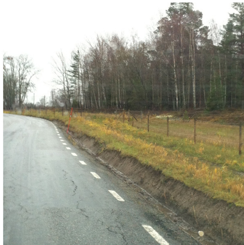
Befintlig ridstig som förbättras för att ge bättre komfort och framkomlighet samt förbättrad trafiksäkerhet
