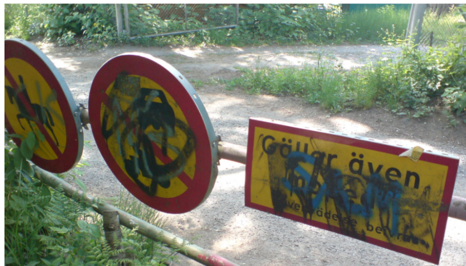
Exempel på vägmärken som behöver bytas ut
