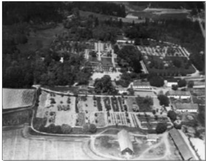
Figur 2: Flygfoto över Ekebyhovs slott och området strax söder om slottet. Bilden är tagen från Ahrenbergs flyg 1936. Källa: Stockholms läns museum.
