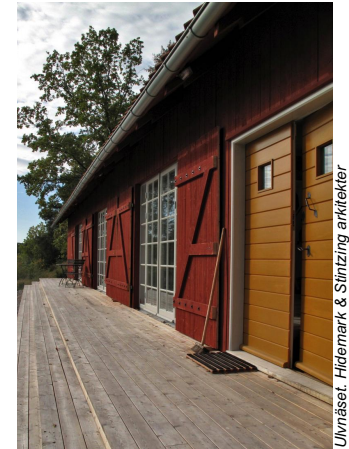
Stora fönsteröppningar med luckor/portar
