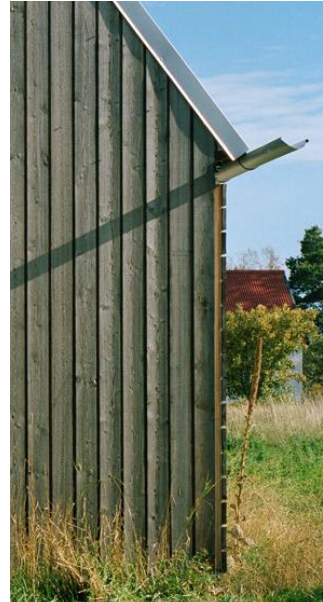
Exempel på grå/järnvitriolbehandlad panel
