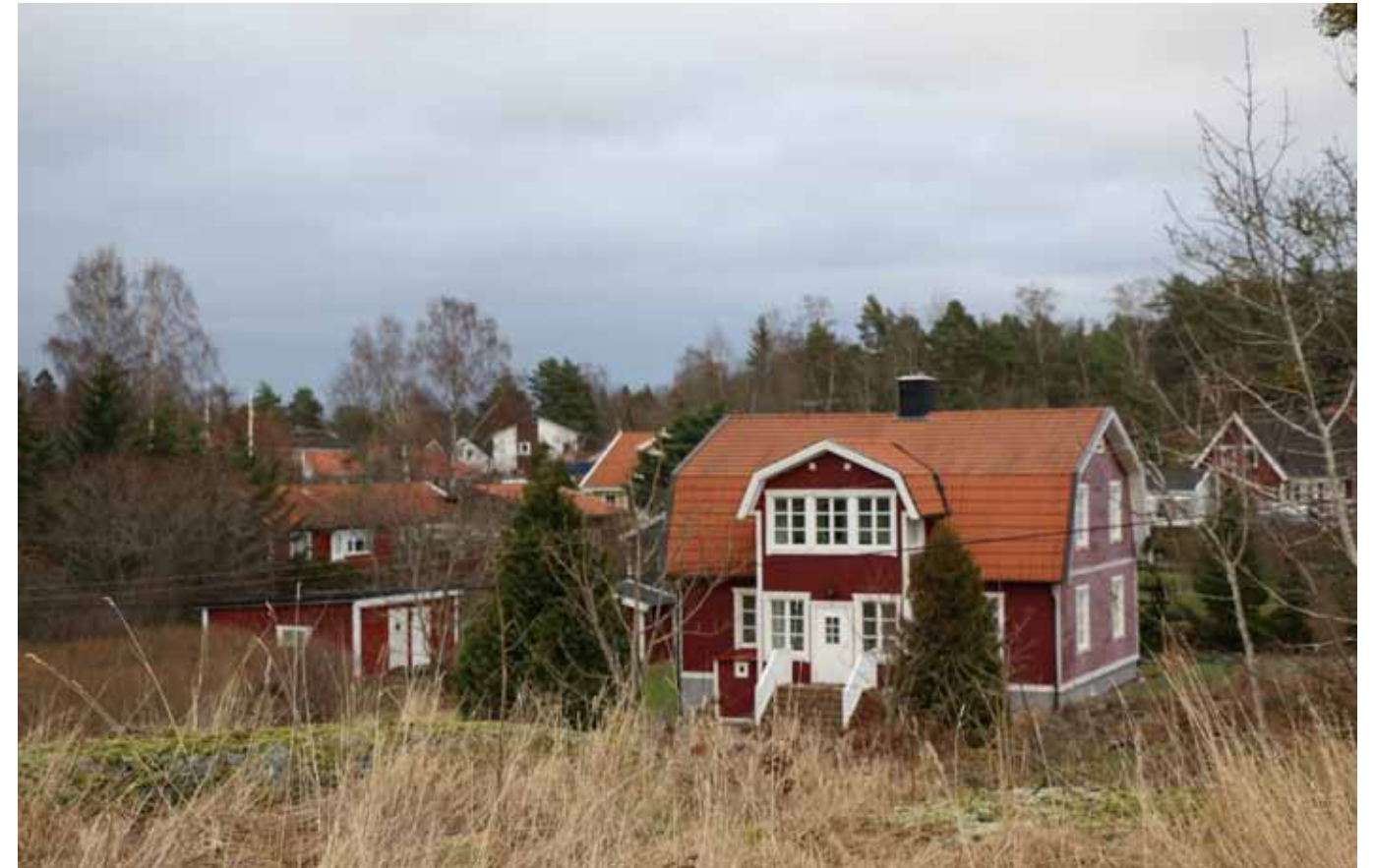
Villabyggnad uppförd omkring 1910-20.
