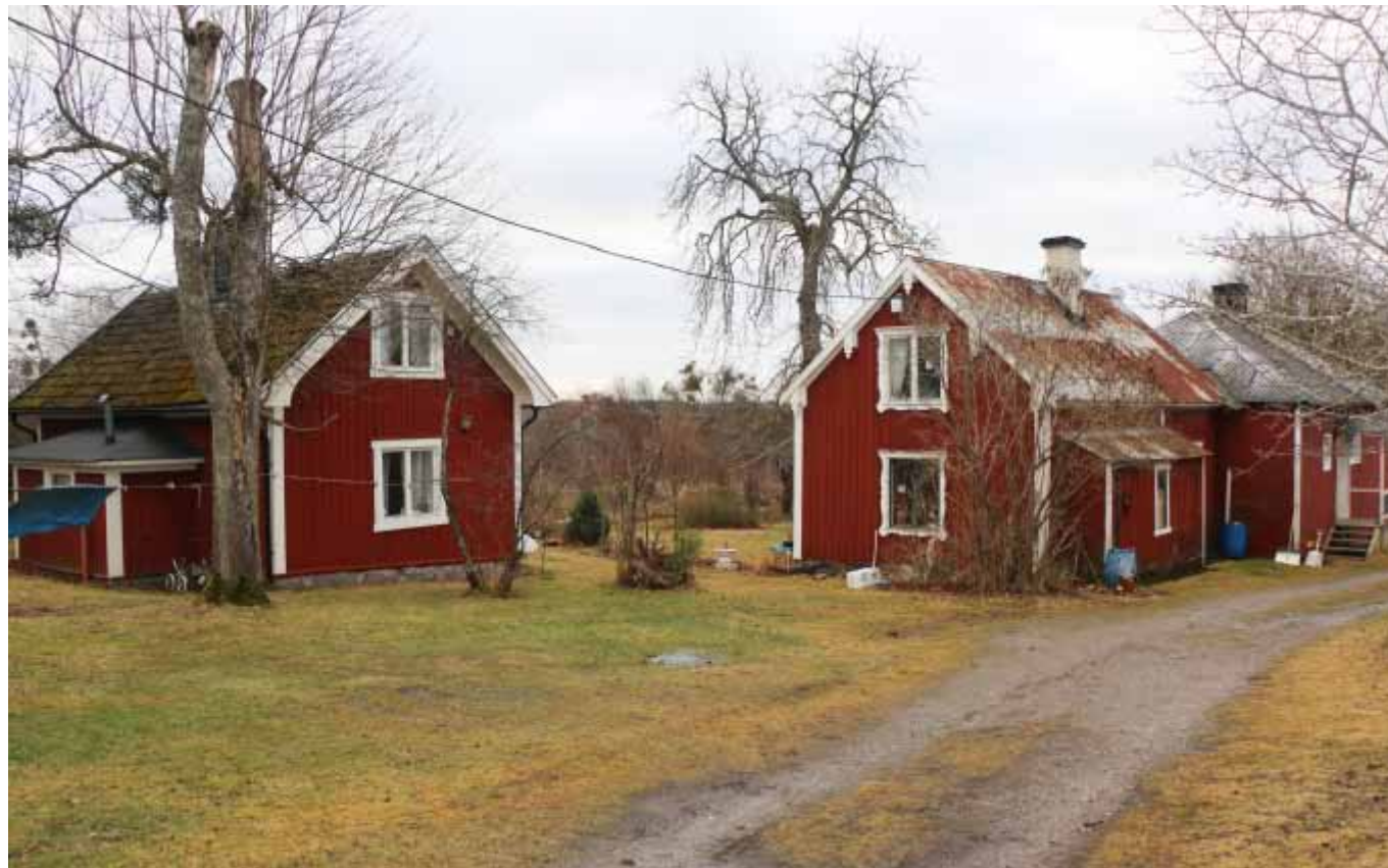
Äldre gårdsmiljö med flera bostadshus och ekonomibyggnader.
