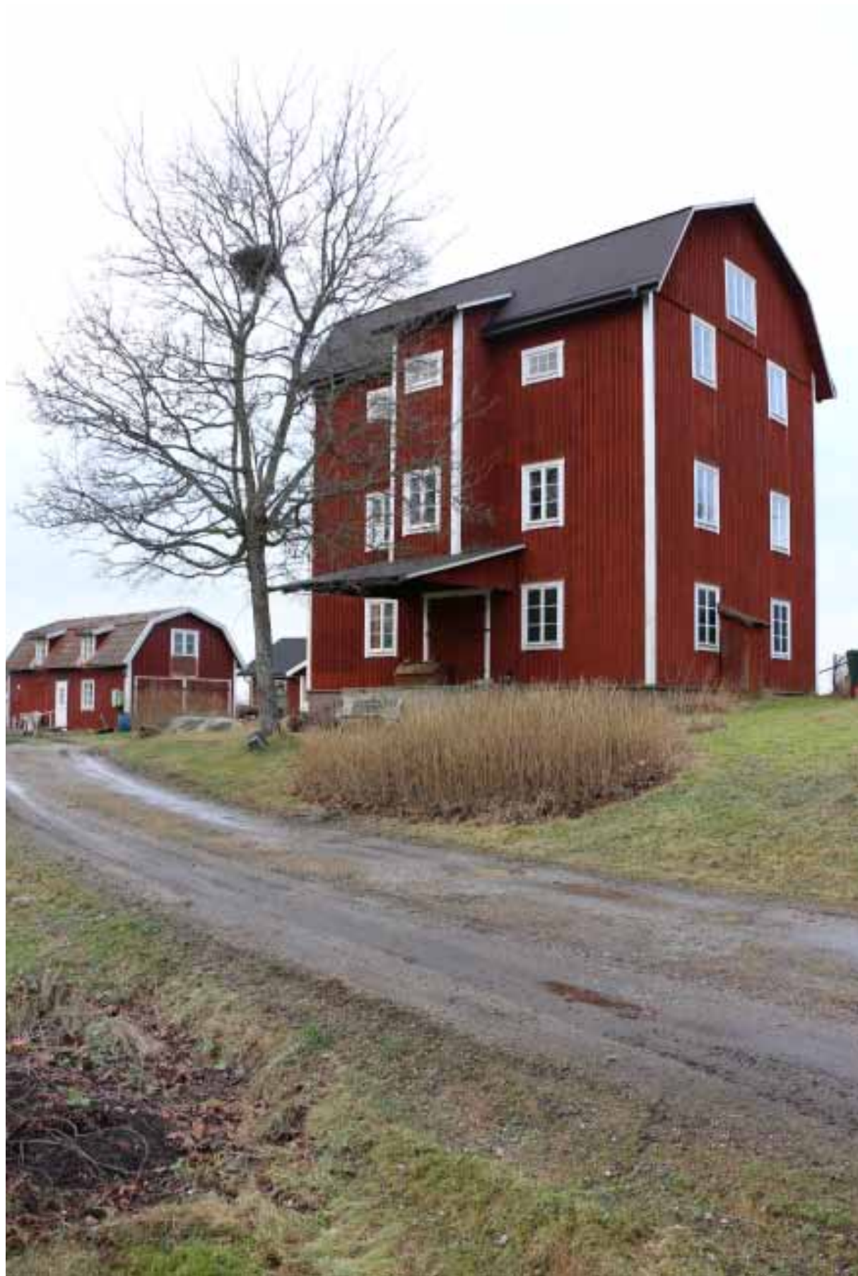
Kvarnbyggnad uppförd under 1930-talet med ett centralt läge i byn är starkt karaktärsskapande.
