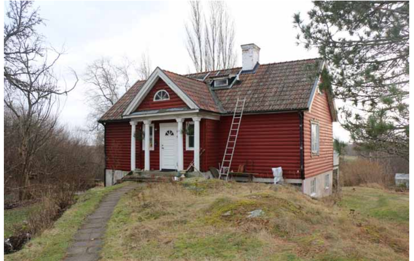
Det dominerande takmaterialet är rött en- eller tvåkupigt tegel.
