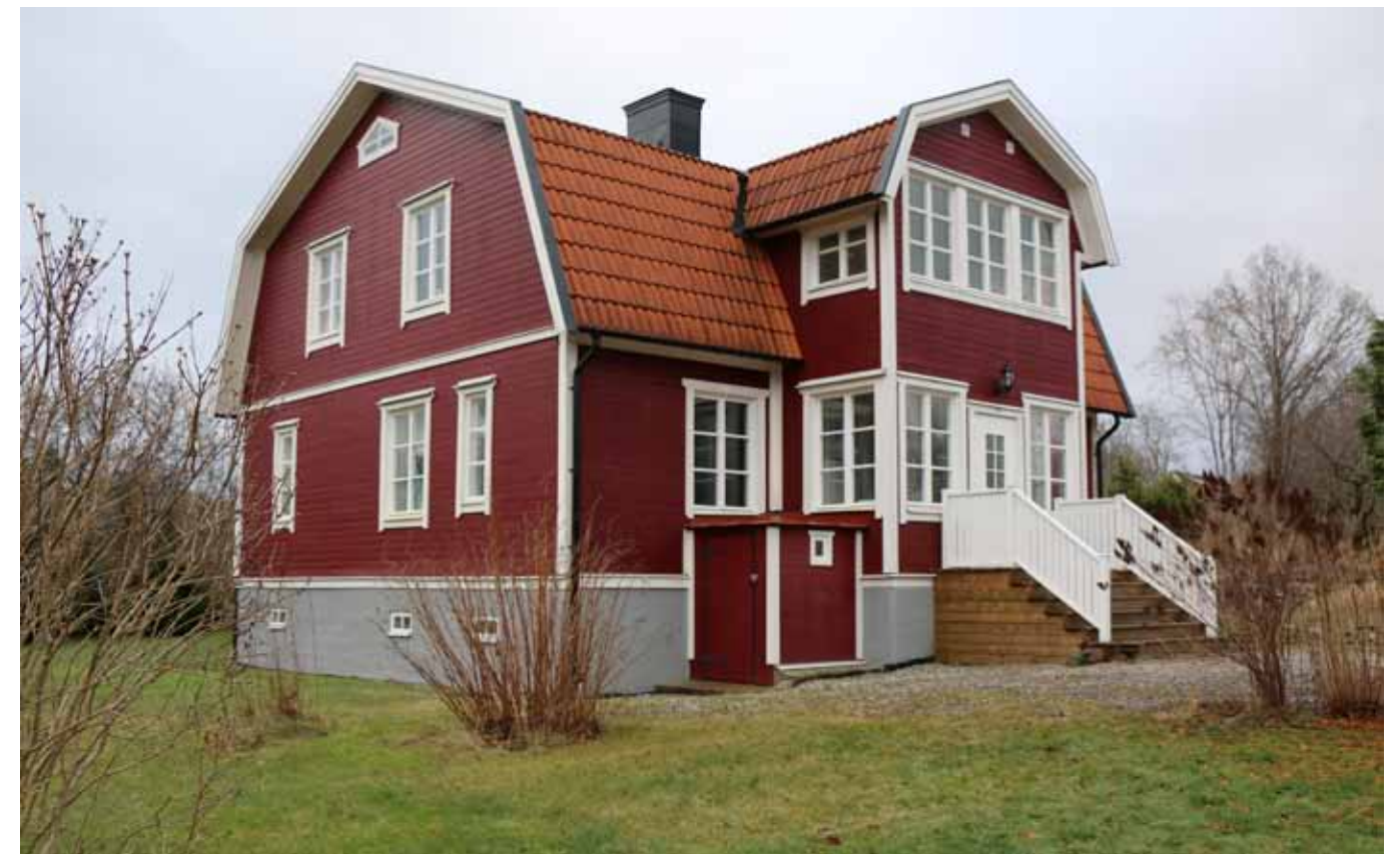
Villabyggnad uppförd omkring 1910-20.
