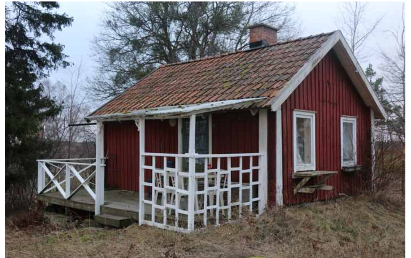
Knuttimrad stuga klädd med locklistpanel. Moderna fönster och dörrar.
