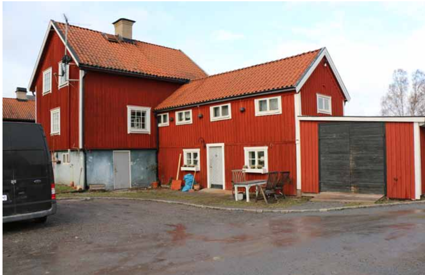
Östra flygel med tillbyggnad.
