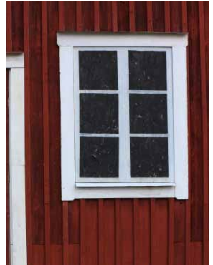
Spröjsade tvåluftsfönster (blindfönster).
