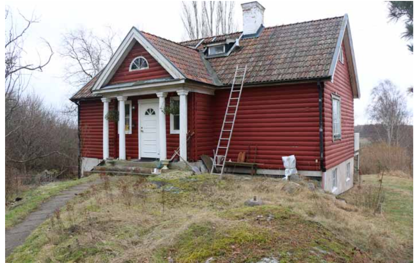
Villa uppförd omkring 1900-10.
