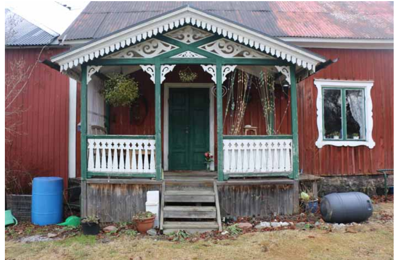
Mangårdsbyggnad med väl bevarad snickarglädjeväranda och entrédörr från sent 1800-tal.
