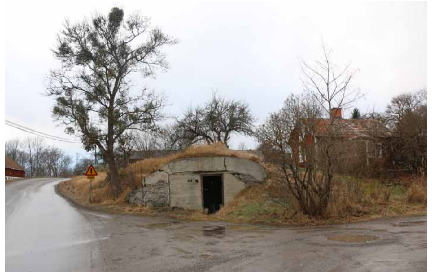
Jordkällare intill Kungsbergavägen.
