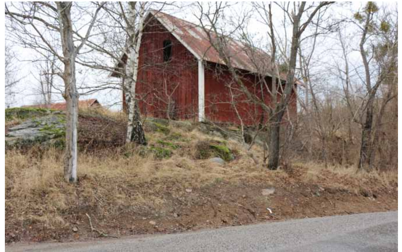
Magasinsbyggnad från vägen.
