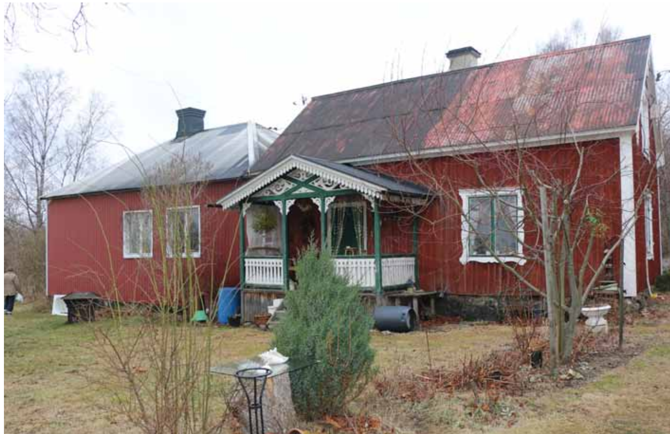
Mangårdsbyggnad med tillbyggnad inklädd med plåtpanel.
