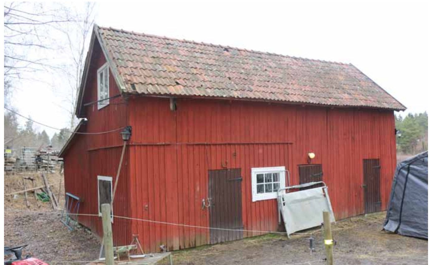
Det dominerande takmaterialet är rött en- eller tvåkupigt tegel.
