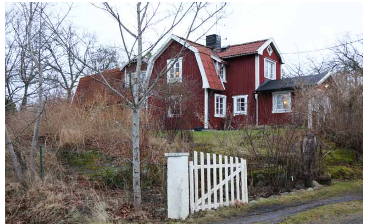
Villa uppförd omkring 1914, senare tillbyggd.
