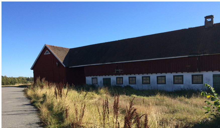
Ladugårdsbyggnad på Kungsberga 1:34.
