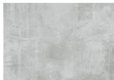
Delar av sockelvåning av matrisgjuten betong/betong.
