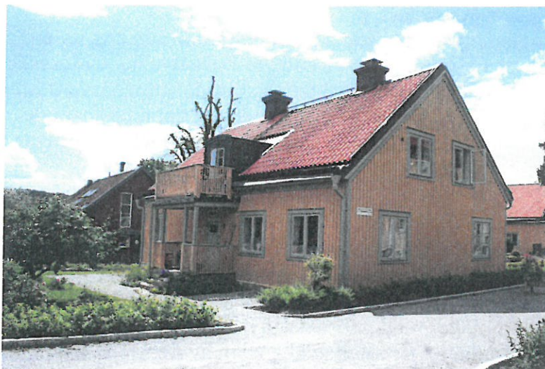
Exempel (område 4) på en nyligen uppförd villa i Järla sjö, Nacka, med sadeltak och träpanel. (foto: Elisabet Hansson)
