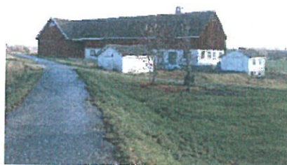
Ladan sedd norrifrån, på gångvägen vid Kungsbergavägen
