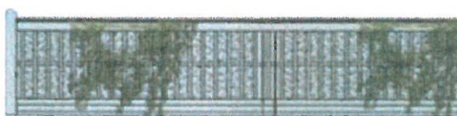
1,5 meter hög bullerskärm på vägens östra sida.
