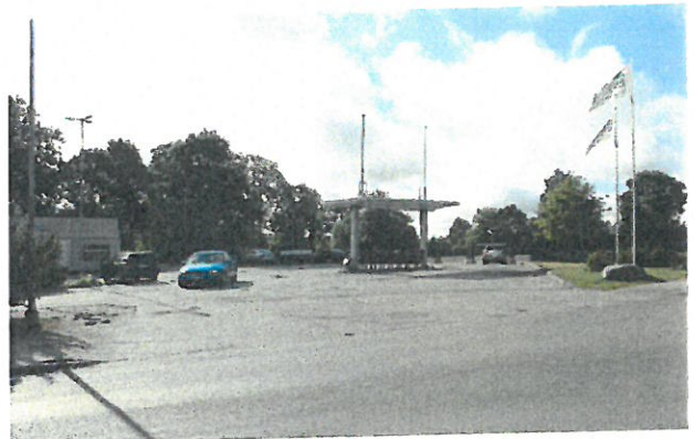
Den nerlagda bensinstationen.
