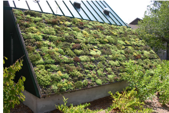
Gröna tak kan rena luften och isolera.
