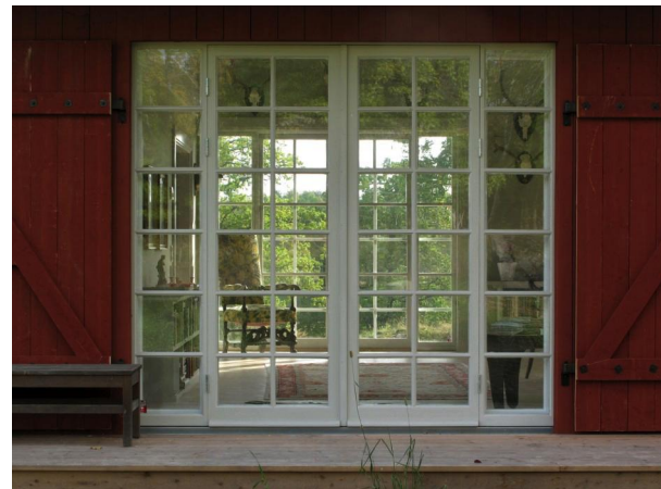
Exempel på generösa ljusinsläpp med spröjsade träfönster.
