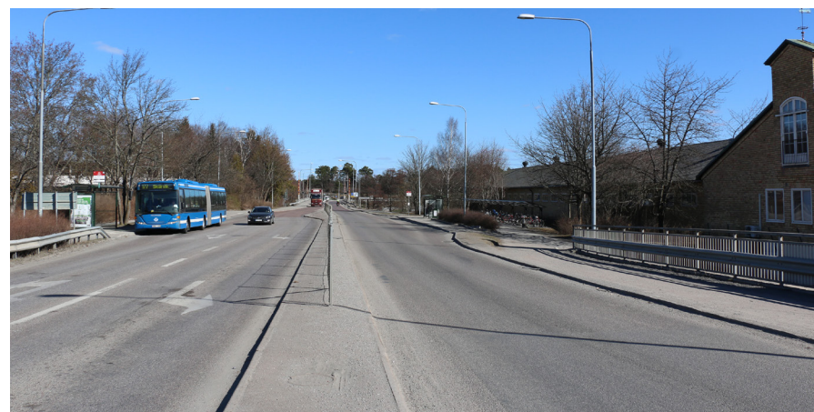
Befintlig bussdepå längs Ekerövägen
