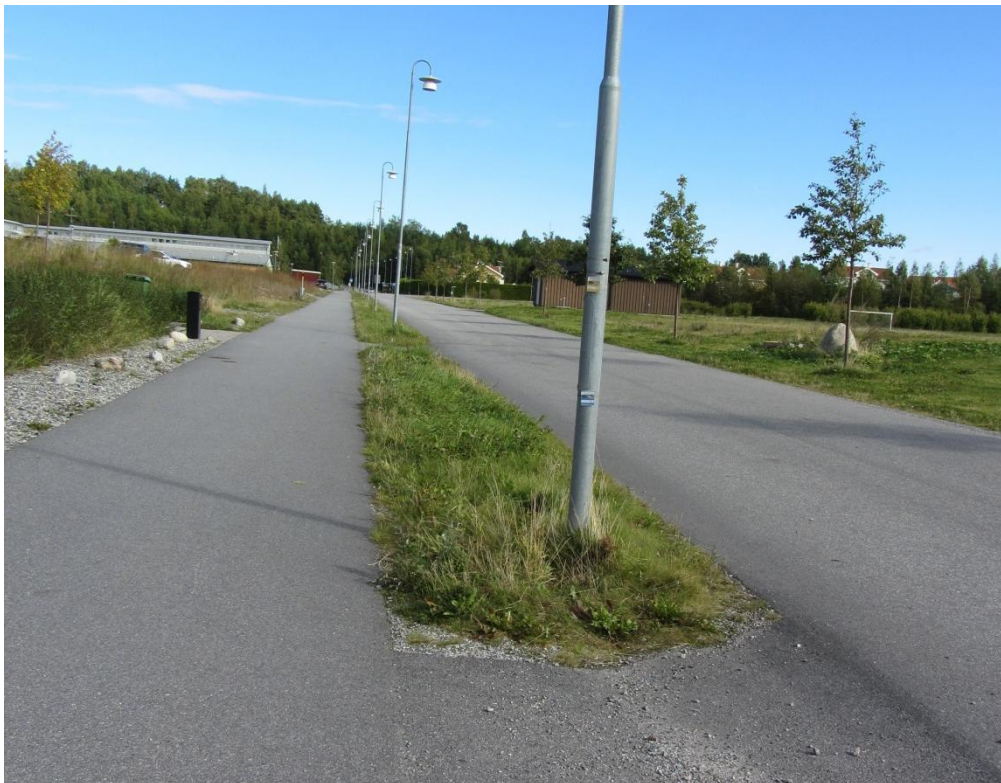
Figur 10. Vy över det mjukt skålade diket mellan GC-banan och Sanduddsvägen.
