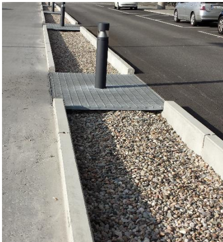
Figur 15. Exempel på makadamdike med släpp i kantsten vid permeabel övergång från Malmö. Foto: Ramböll
