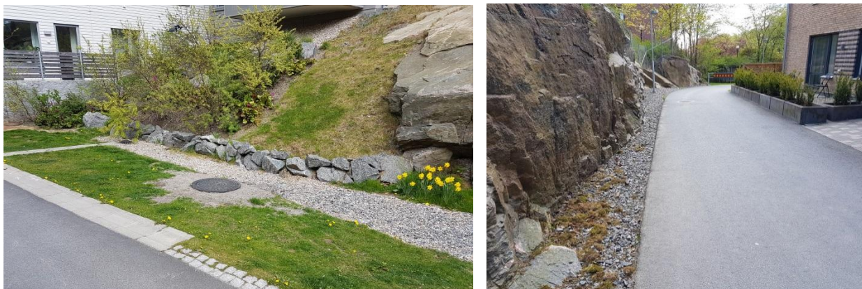
Figur 16. Exempel avskärande åtgärd i form av grussträng invid bergsslant i Göteborg. Foto: Ramböll
