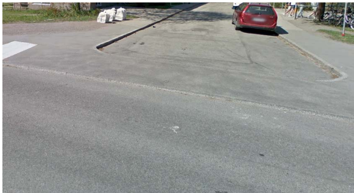
Bild som visar exempel på genomgående gångbana med avfasad kantsten i körriktningen (Ritarvägen, Bromma).
