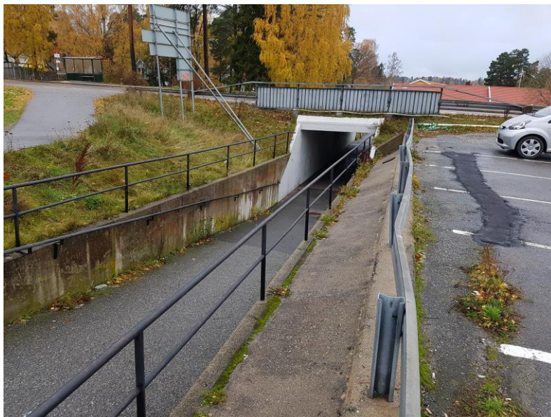
Figur 2. Ekerövägen, bro över gc-väg.
