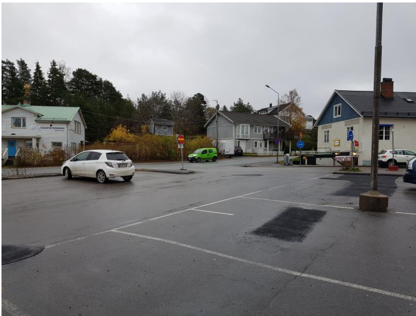
Figur 3. Parkering med hårdgjorda ytor på fastigheten Träkvista 2:116.
